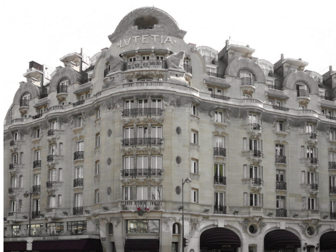
L'hôtel Lutetia construit par Lucien Boileau
