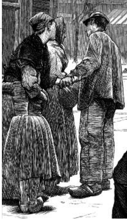
« TRAVERSÉE D'UNE RUE SOUS LES BOMBARDEMENTS - UNE SCÈNE À PARIS » (DÉTAIL). CI-DESSOUS : LA SCÈNE ENTIÈRE PARUTION DU 27 MAI 1871
