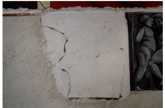
Pose de trois couches d'enduits de plus en plus fins
